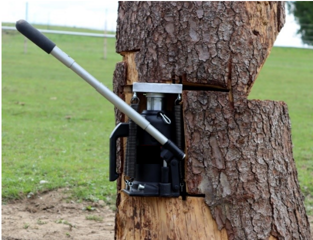
Eingebauter und vorgespannter Hebezyylinder
